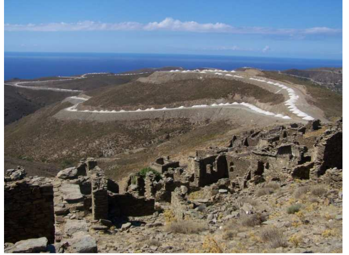
Terk edilmiş bir Rum yerleşmesi olan Sazak ve çevresinde, neredeyse tüm yarımada'yı kaplayan yeni yol yapımı çalışmaları.
